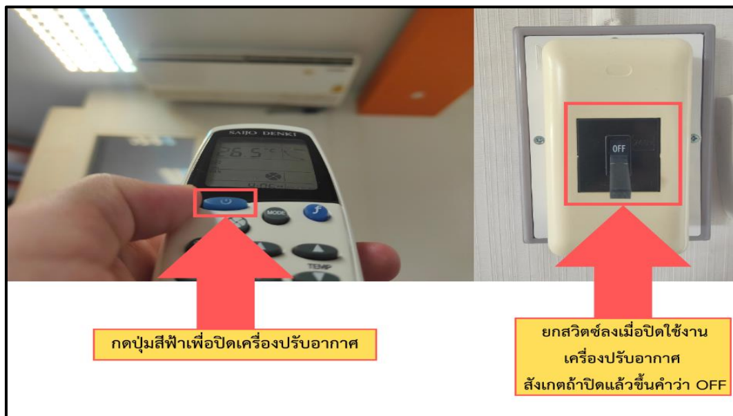
ภาพที่ 3.41 การปิดเครื่องปรับอากาศ
