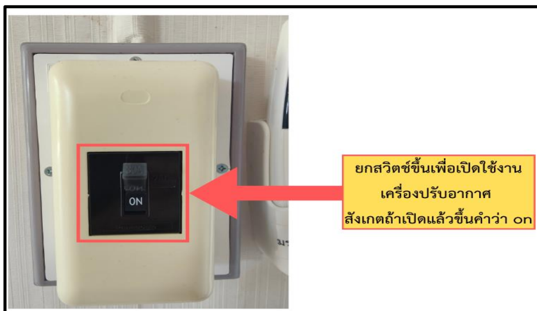
ภาพที่ 3.10 การเปิดสะพานไฟของเครื่องปรับอากาศ
