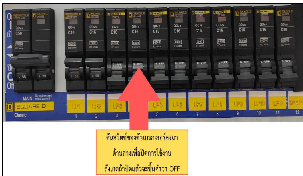
ภาพที่ 3.46 การปิดแผงเซอร์กิตเบรกเกอร์จุดที่ 2
