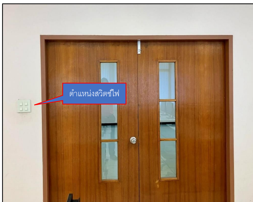
ภาพที่ 8 ตำแหน่งสวิตช์ไฟแสงสว่างภายในห้องปฏิบัติการคอมพิวเตอร์
