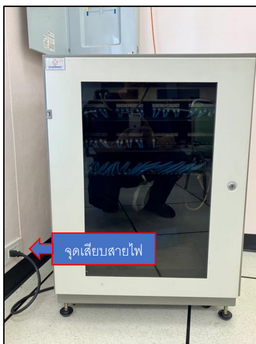
ภาพที่ 19 ตู้เก็บอุปกรณ์เครือข่ายคอมพิวเตอร์ (ตู้ switch)
